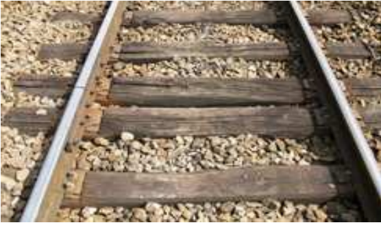
Rails courts sur traverses bois
